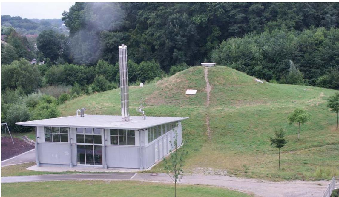
Abbildung 34: Heizzentrale der solaren Nahwärme Wiggerhausen in Friedrichshafen mit in einen grünen Hügel integrierten, saisonalen Wärmespeicher mit 12.000 m<sup>3</sup> Wasservolumen (Quelle: Solites)
