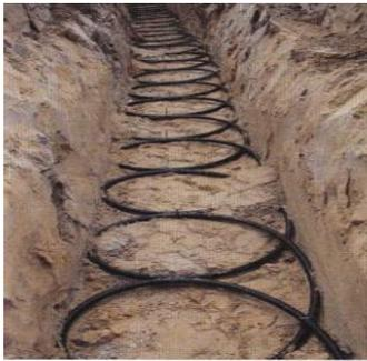
Abbildung 26 Bau eines Grabenkollektors[10]
