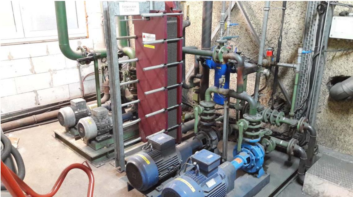
Abbildung 4: Wärmeübertrager zur Kühlung der Induktionsspule eines Schmelzofens mit Pfefferwasser (Foto: Solites)
