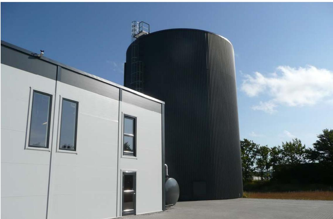
Abbildung 31: Beispiel eines oberirdischen Stahlspeichers (Foto: Solites)
